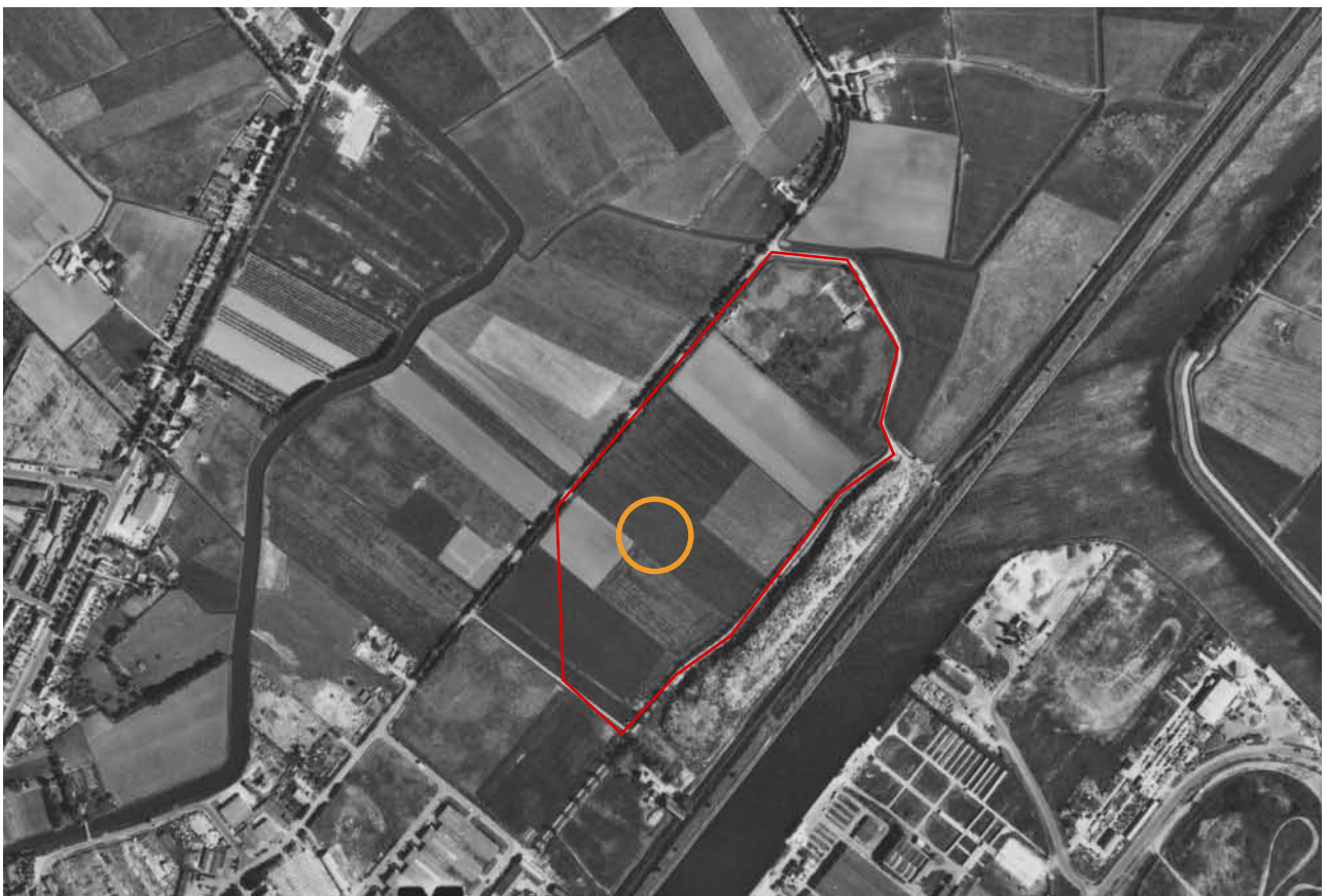
Fig. I - 3 Het plangebied op een luchtfoto uit 1974 (rood omkaderd). Het onderzoeksgebied is oranje omcirkeld. Bron: SCEZ
