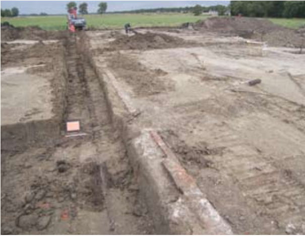
Fig. V-9 Zicht op de zgn 'tuinmuur' en de houten goot ten noorden van de muur
